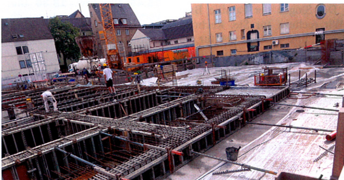
Fortschritt nach Plan beim PATRIZIA Bauvorhaben im Augsburger Domviertel.
