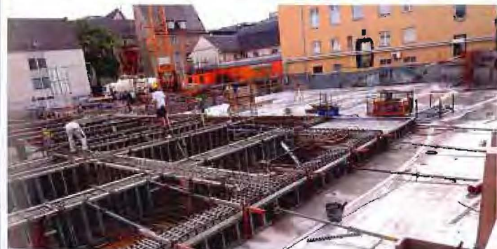
Fortschritt nach Plan beim PATRIZIA Bauvorhaben im Augsburger Domviertel.
